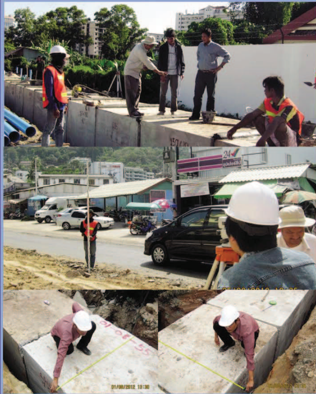
งานตรวจสอบงานวางท่อเหลี่ยมคอนกรีตเสริมเหล็ก
